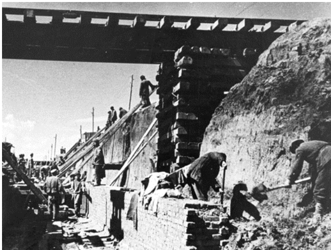
Рисунок 7 – На строительстве Безымянской ТЭС. Октябрь 1941 г.
